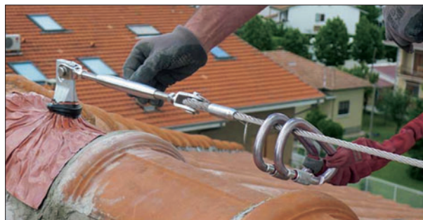
Figura 1 - Incorporazione tra ancoraggio e struttura di supporto.
